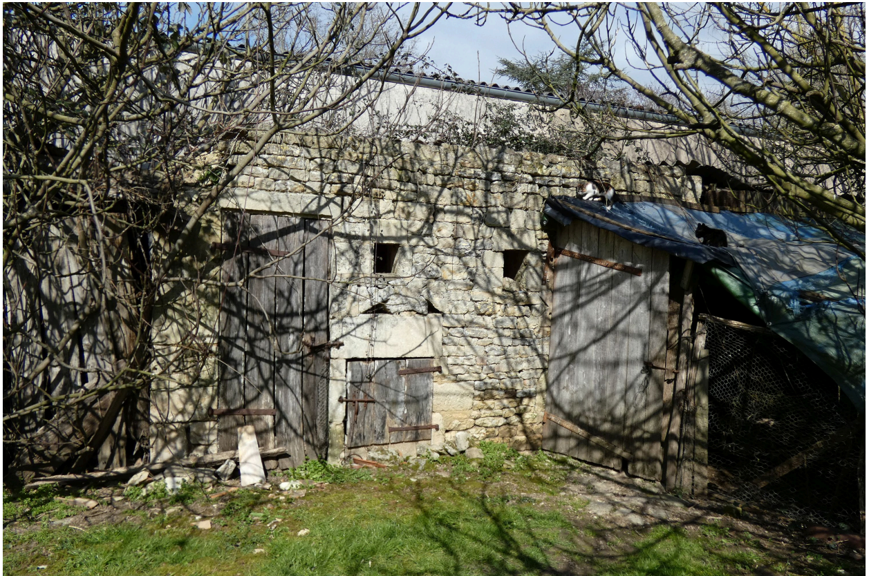
Toit à porcs sur le côté nord de la cour.
