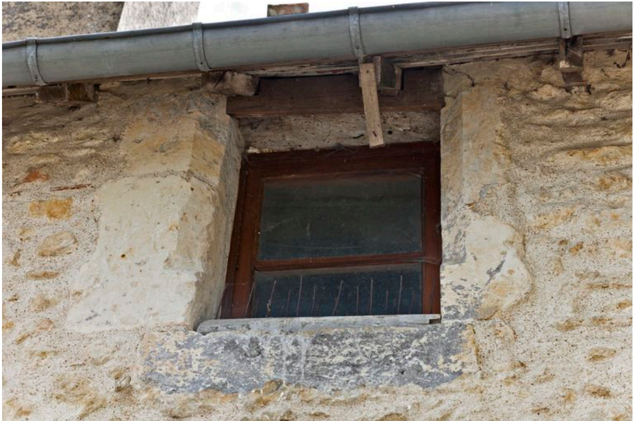
Ancienne fenêtre passante gauche de l'étage du logis
