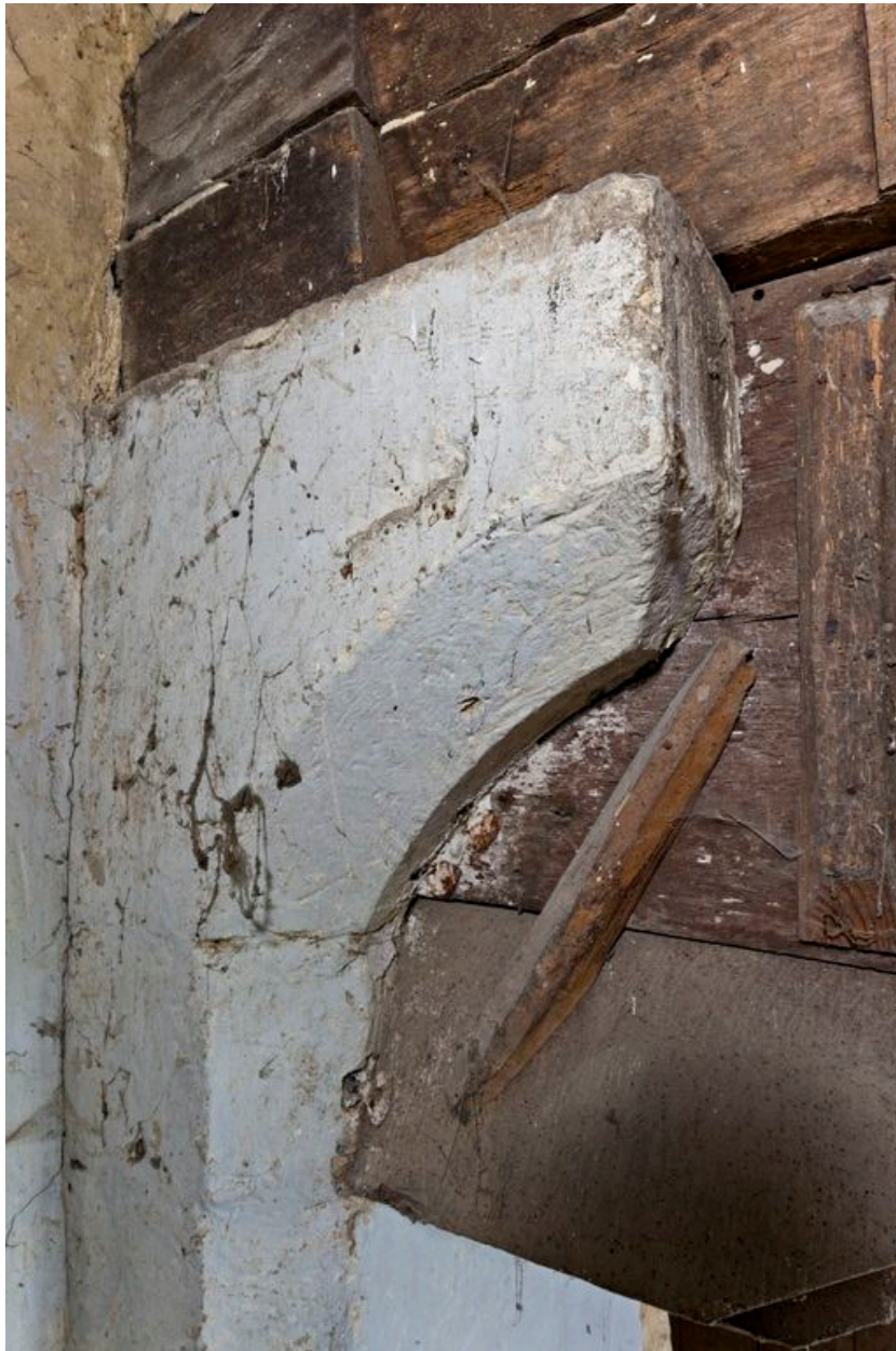
Face interne de la console droite de la cheminée de la pièce 4
