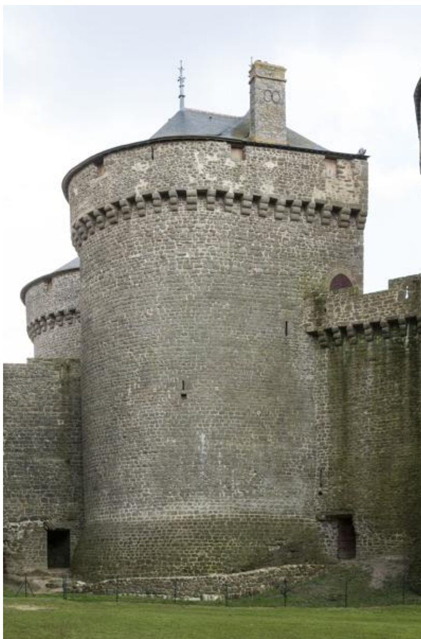
Tour occidentale du châtelet, depuis l'ouest.
