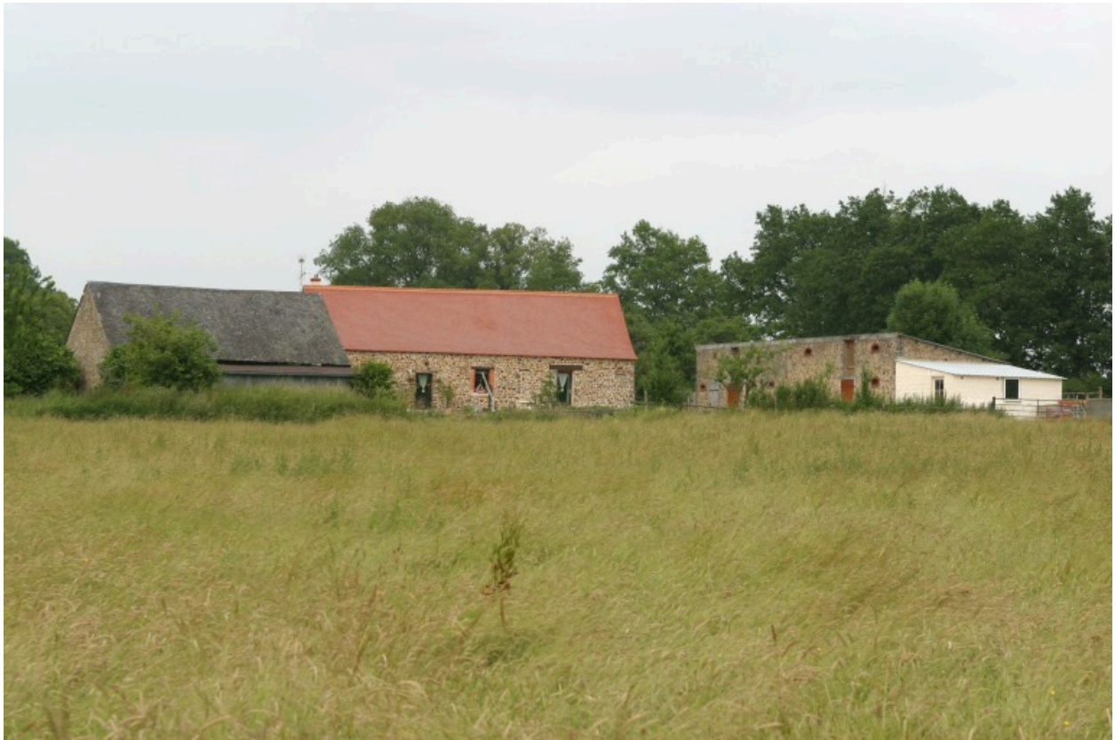
Vue d'ensemble depuis la route de Thorigné au sud : la remise, le logis, l'étable-porcherie.
