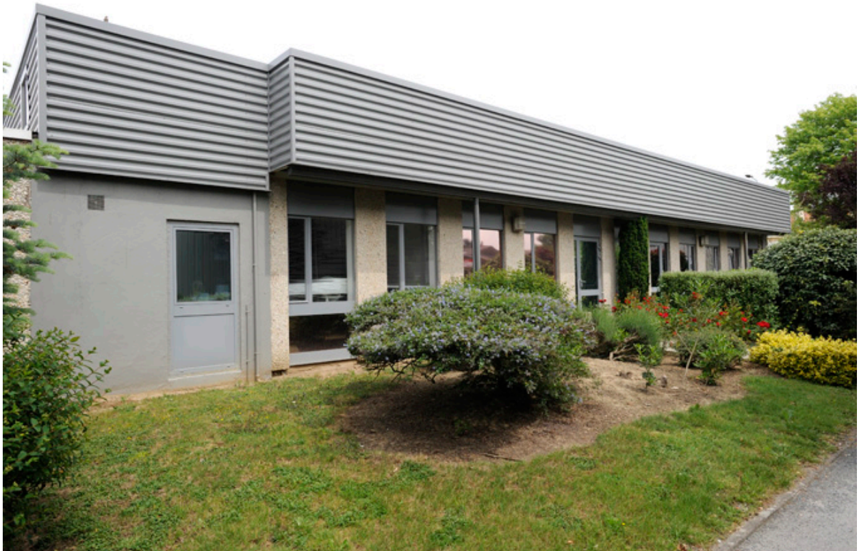
Vue des anciens locaux de l'entreprise Chupin-Immobilier, depuis le sud.
