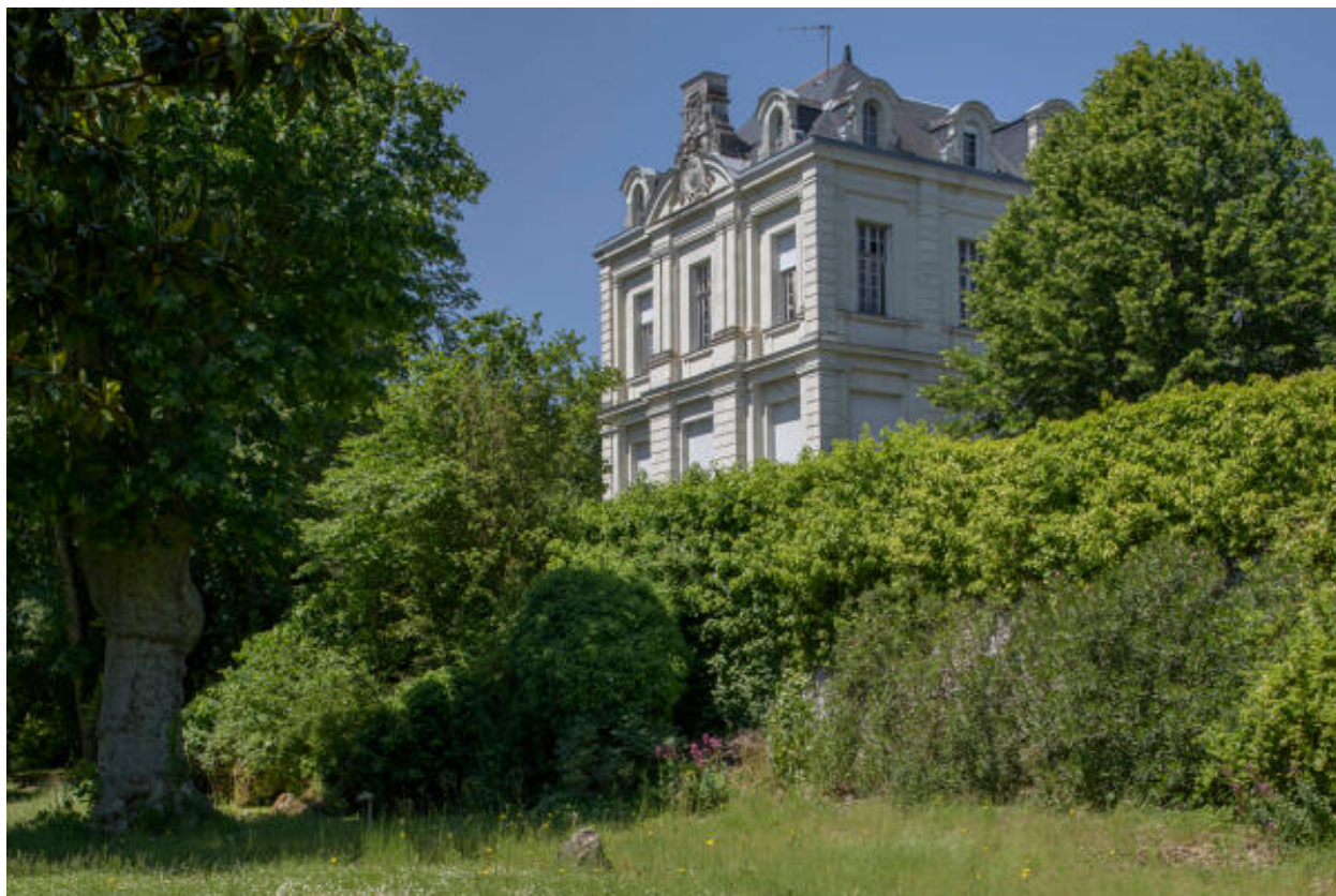
Quartier des hommes. Vue du bâtiment n° 1 construit par Ernest Dainville en 1891.
