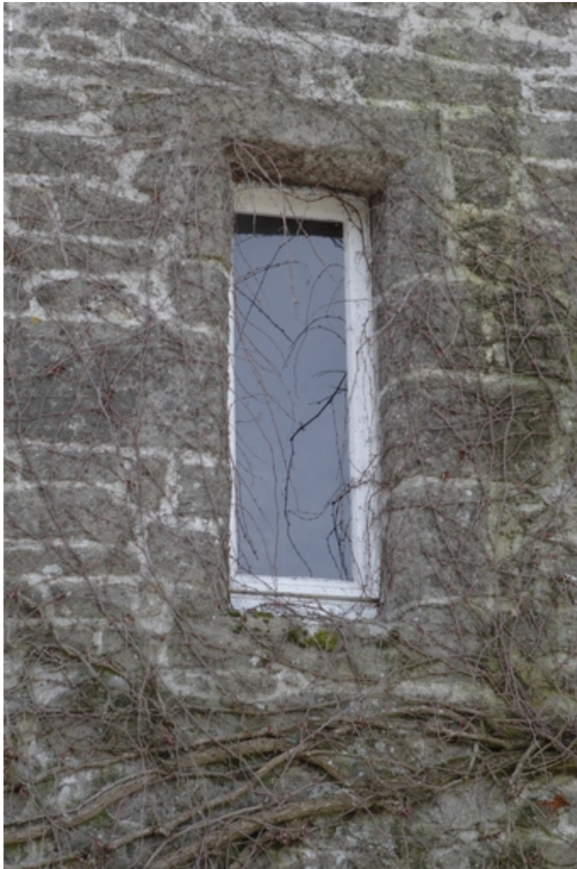
Façade nord. Premier étage. Détail de la fenêtre est.
