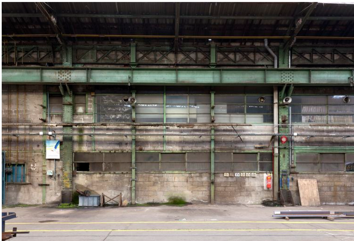
Atelier de découpe : structure métallique et remplissage en parpaings.
