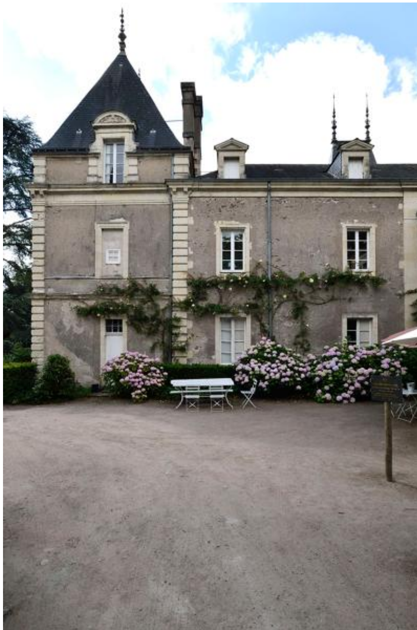
Les Vaults. Château. Façade nord. Vue du pavillon est.
