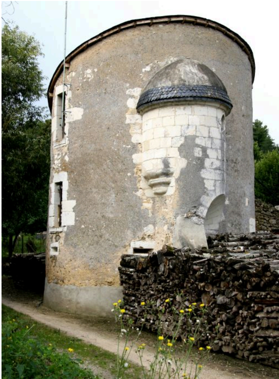
Tourelle : vue de volume.
