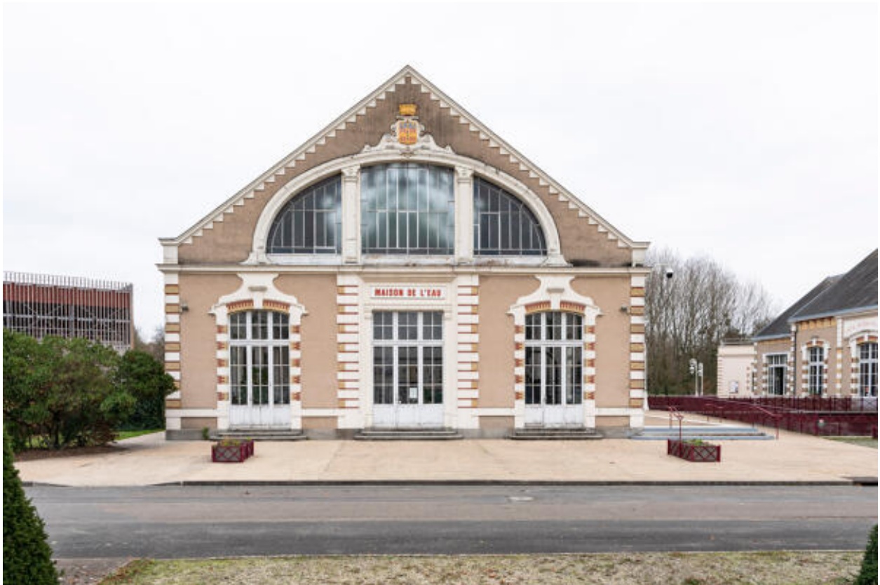
Vue de l'usine des eaux.
