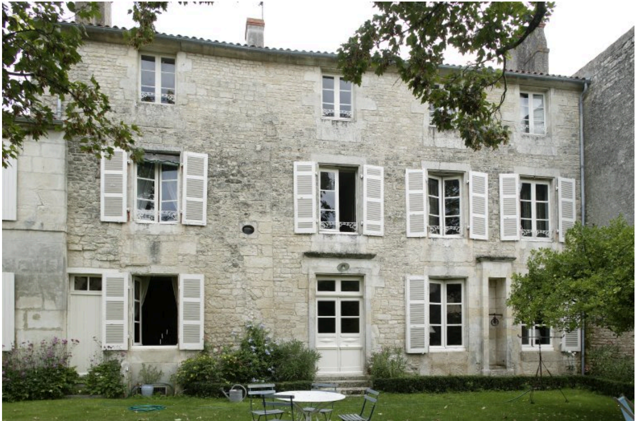
Façade postérieure, donnant sur le jardin.
