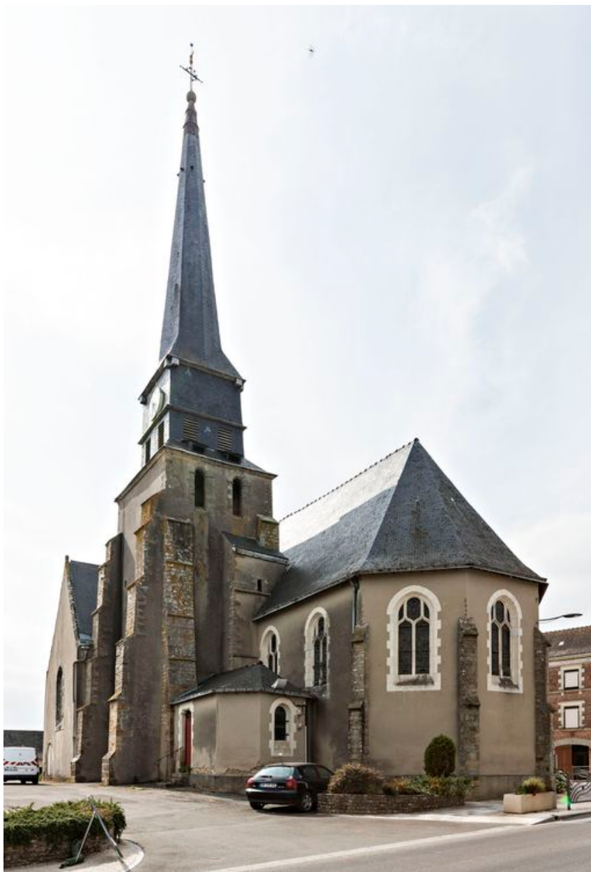
Vue d'ensemble de l'église depuis le nord-ouest.
