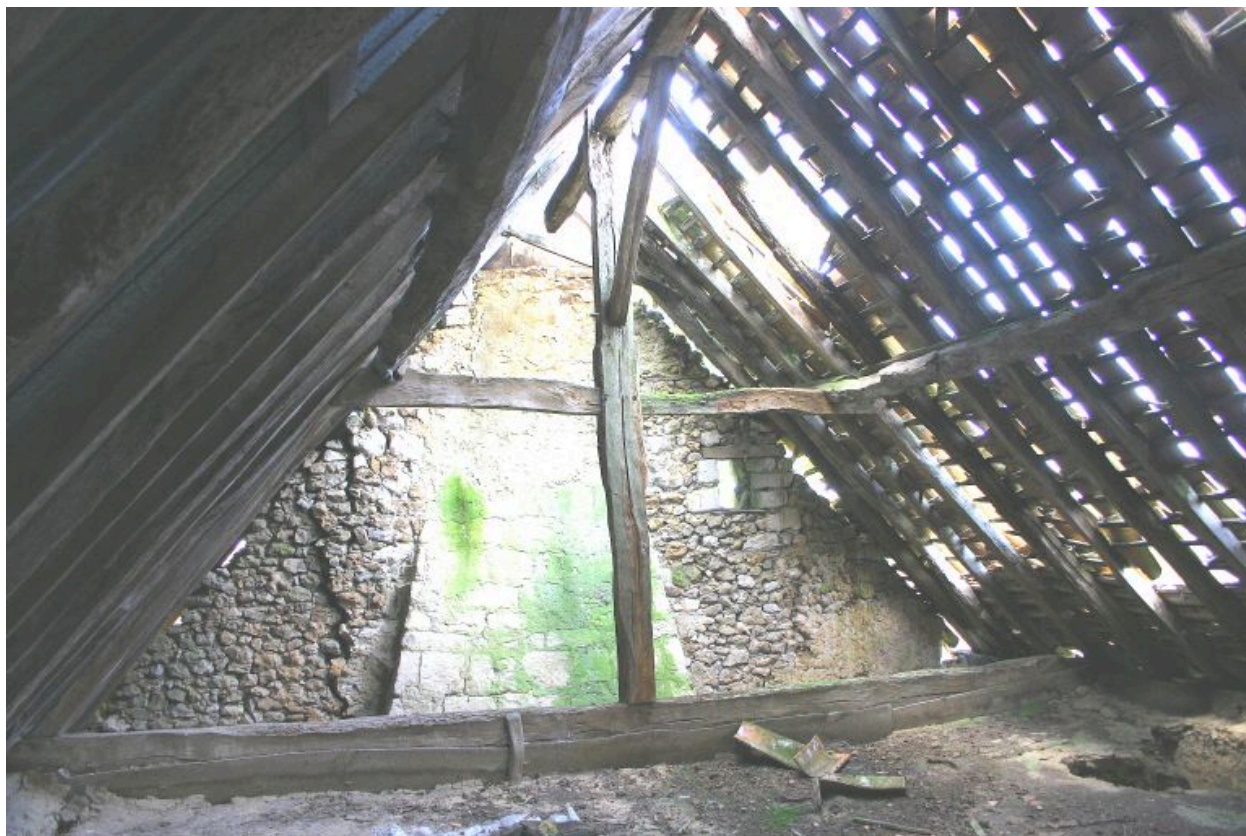
Maison 1 : charpente sous tuile creuse à la baugeoise.
