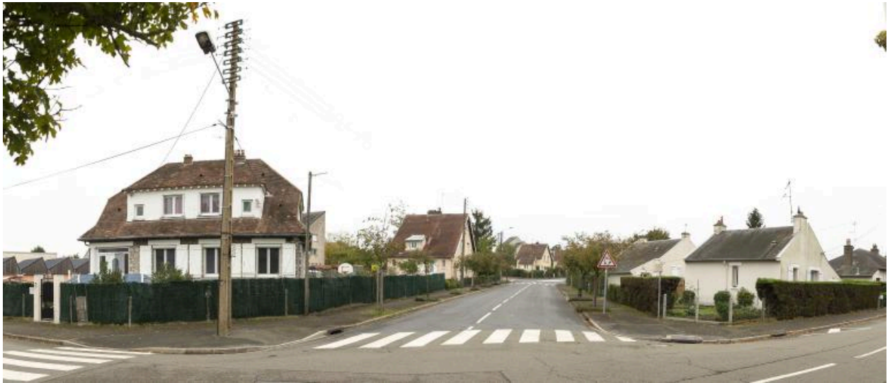
Vue du pavillon à l'angle de la rue Pierre-Sémard.
