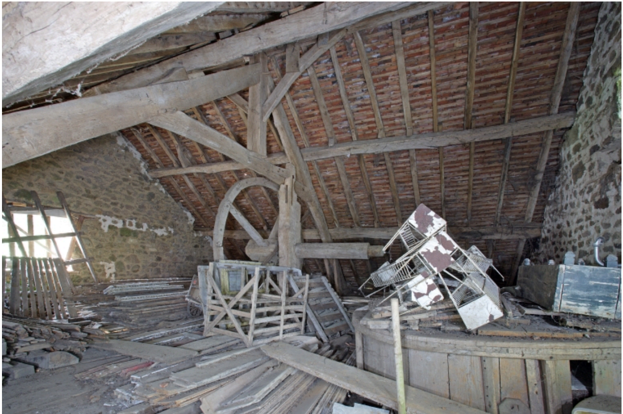
Le moulin à farine sur la Mayenne : le comble vu depuis le nord-est. Au premier plan, les meules dans leurs archures.
