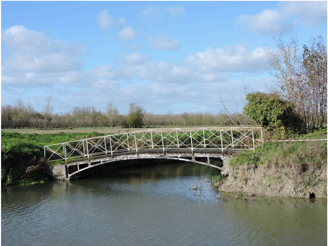
La passerelle sud-ouest vue depuis l'est.
