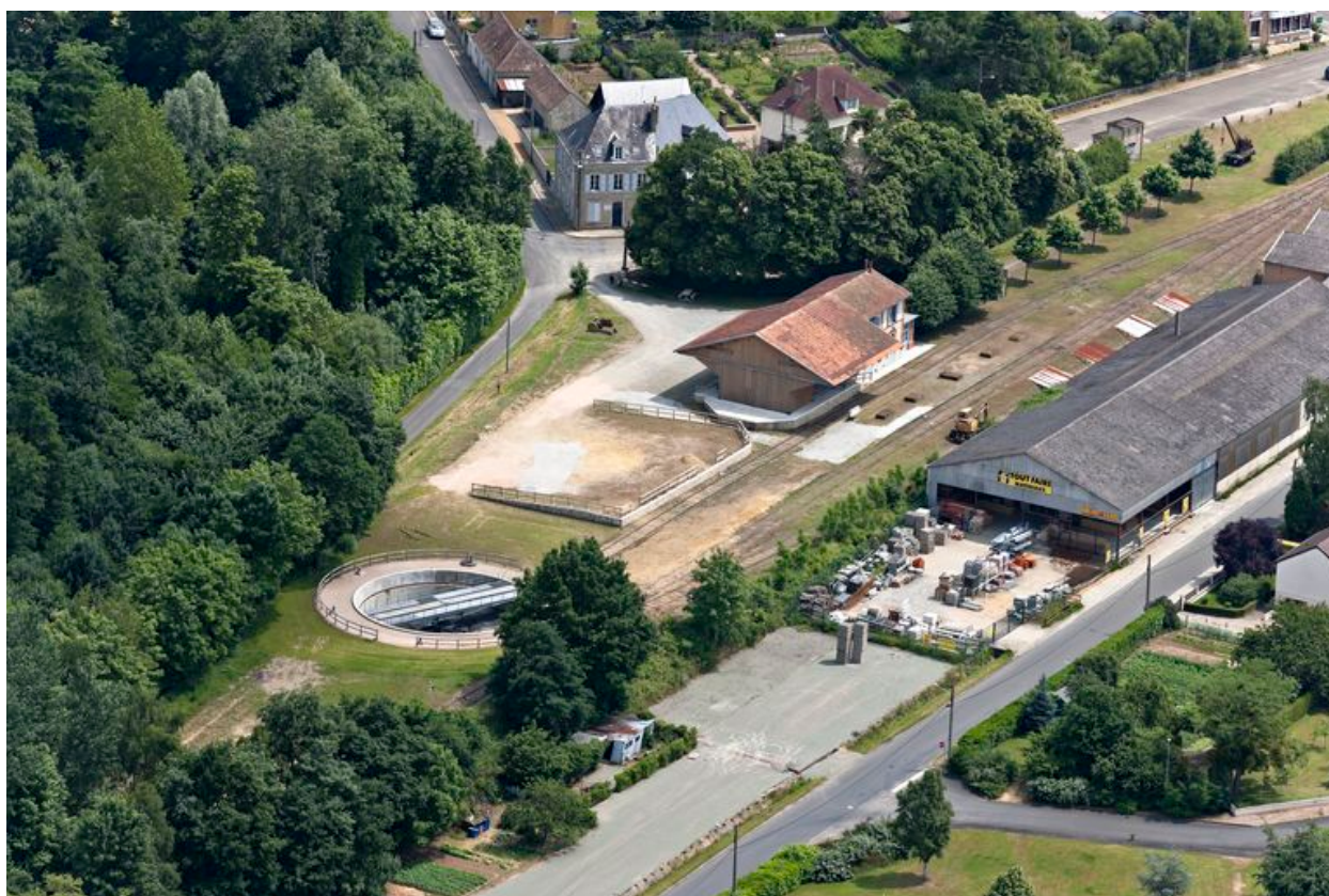
Vue aérienne depuis l'ouest.
