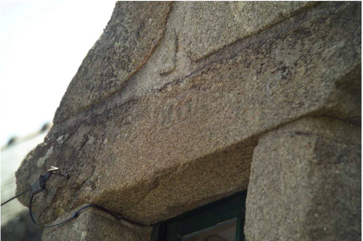
Façade sur rue, détail de la date sur le linteau de lucarne.
