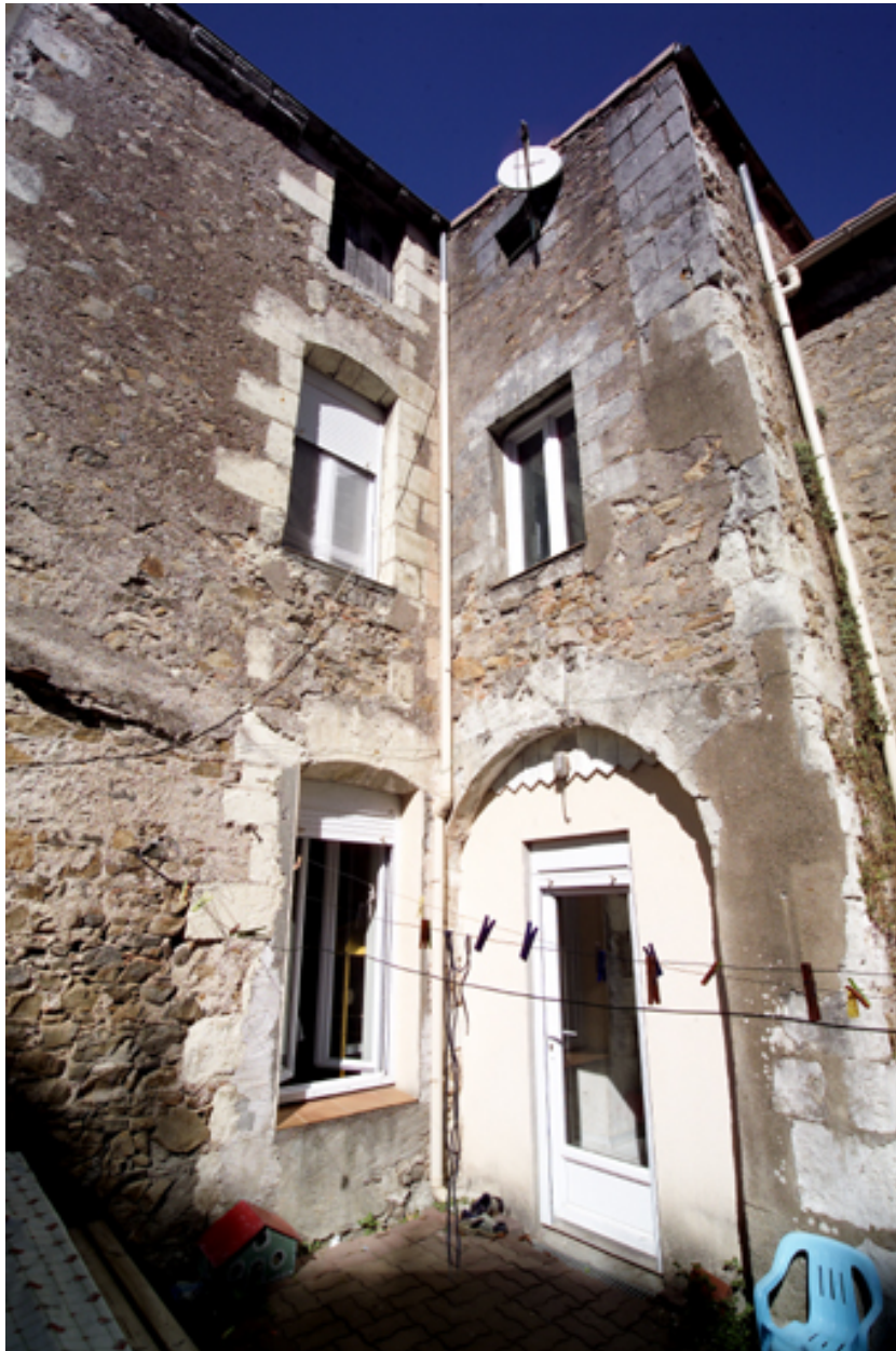
Le corps de l'escalier vu depuis la cour.
