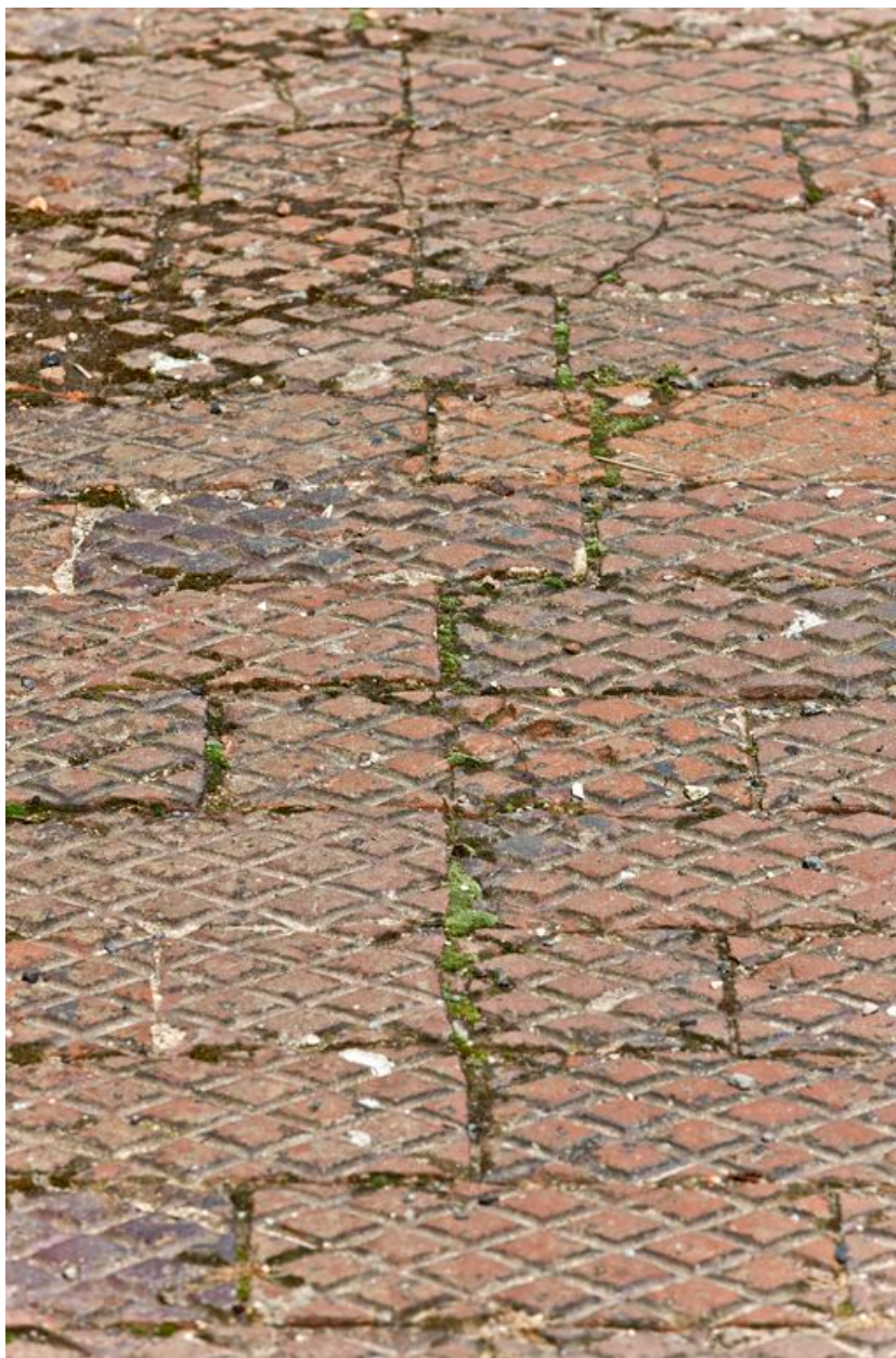
24, rue de la Mairie. Détail du trottoir en briques.
