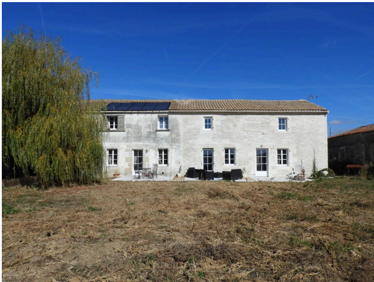
Le logis vu depuis le sud.
