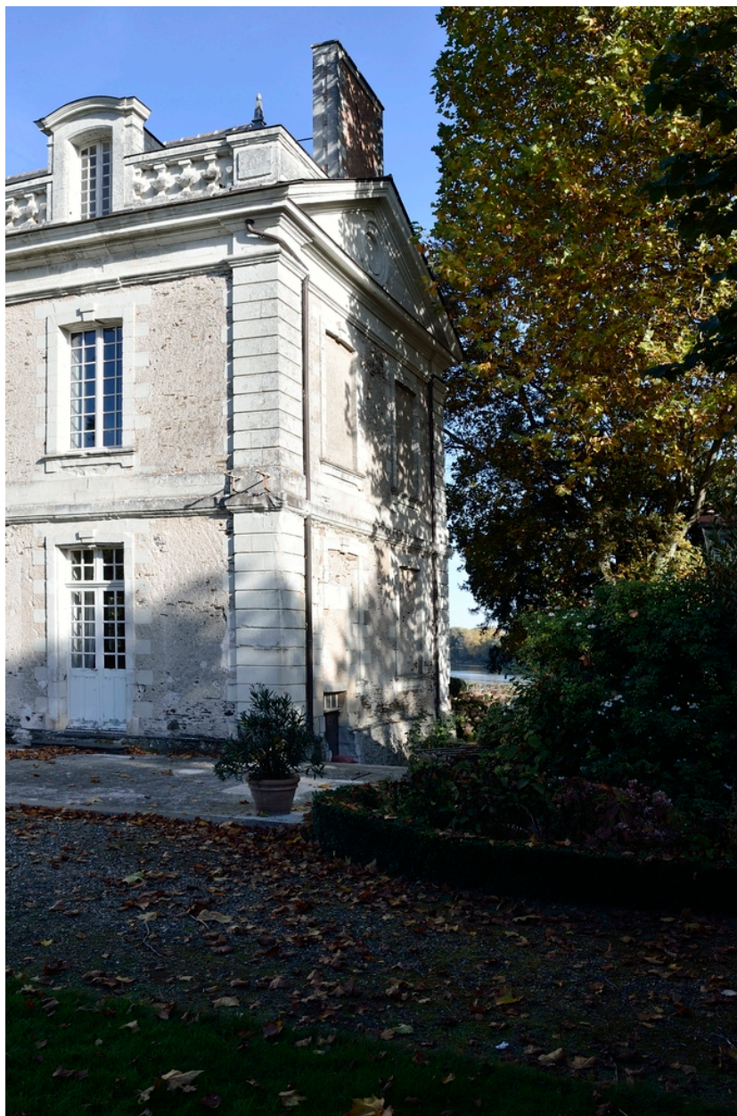
Vue du mur pignon sud.
