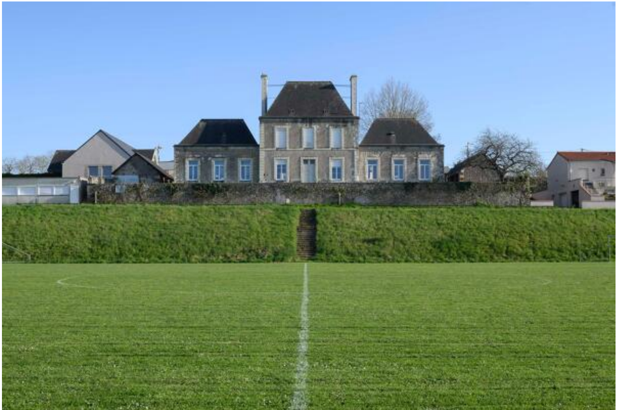
École primaire de garçons Saint-Joseph. Vue d'ensemble depuis le sud.
