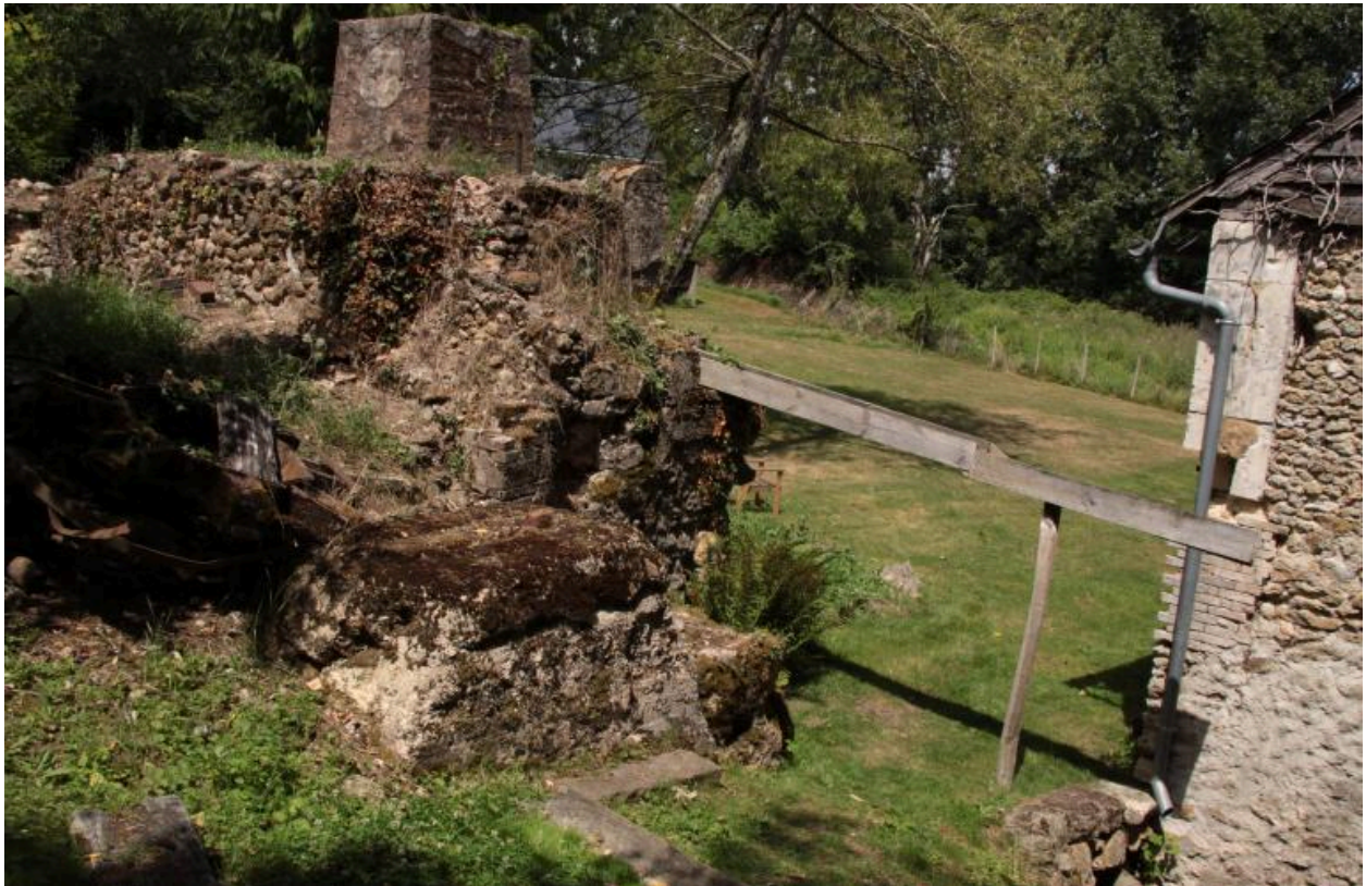
Le dénivelé entre le bief et la roue.
