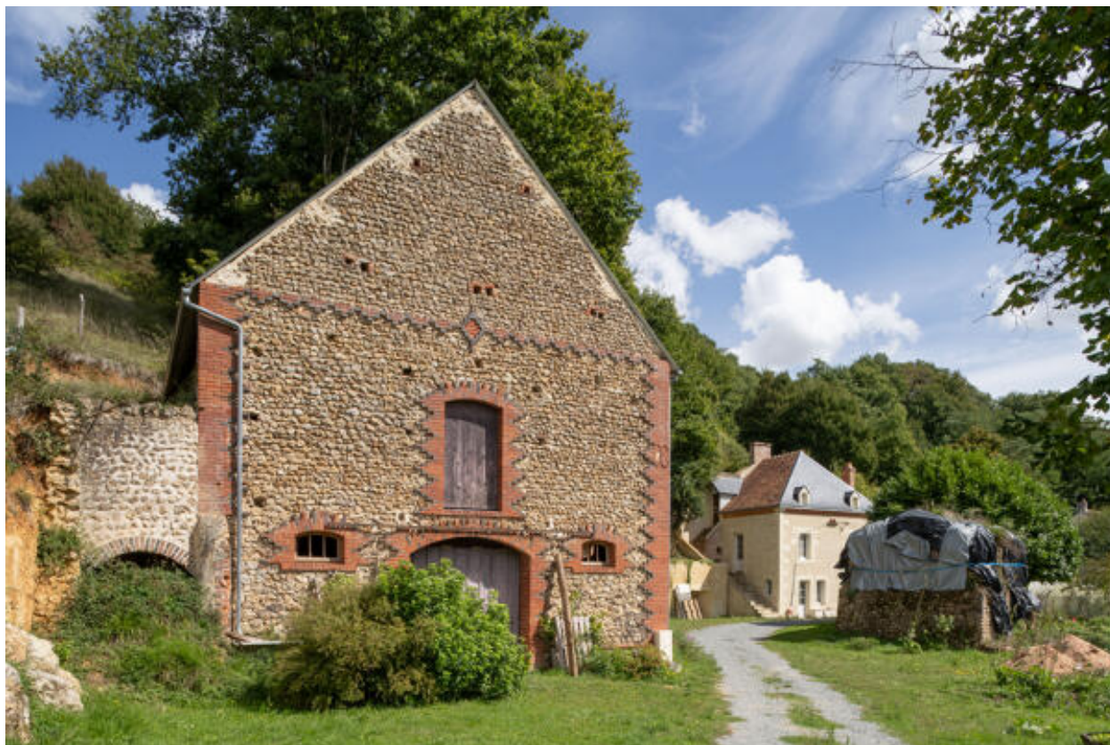
Vue d'ensemble depuis l'entrée du site.
