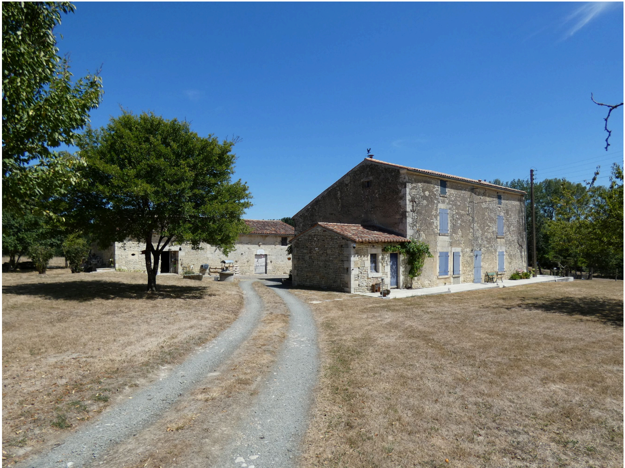
L'ancienne ferme vue depuis l'ouest.
