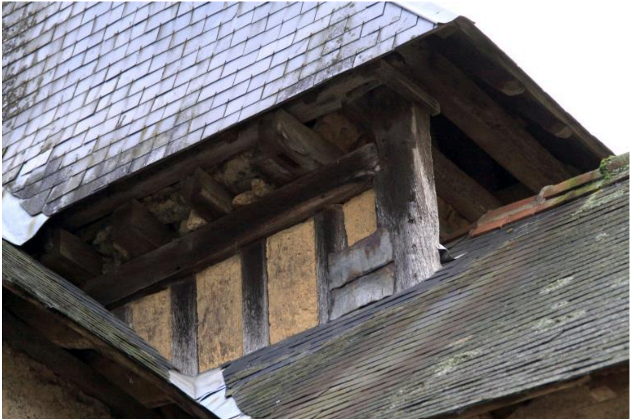
Pavillon, détail du mur en pan de bois côté façade postérieure.
