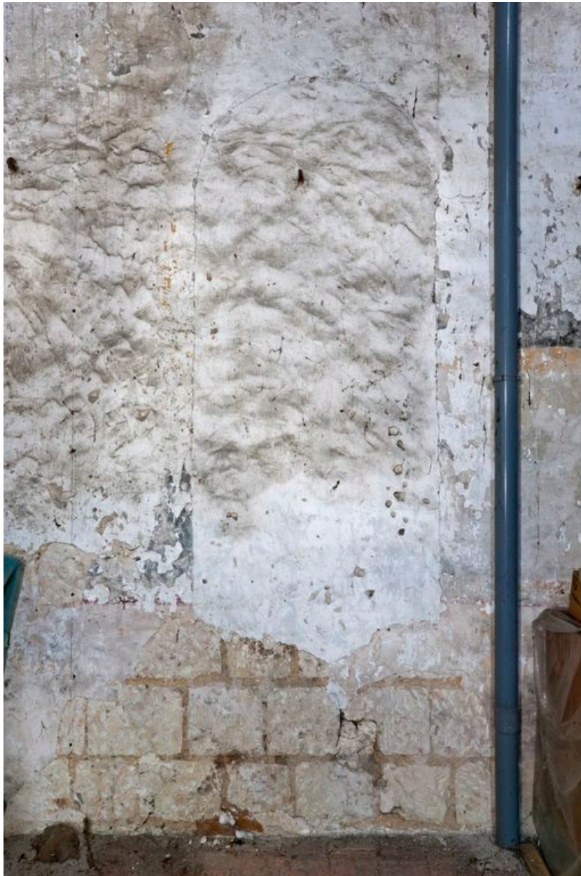
Mur nord, 2e travée : baie en plein cintre obstruée.
