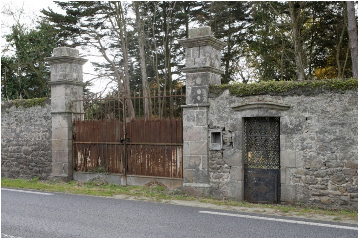
Mur de clôture. Portail d'entrée.
