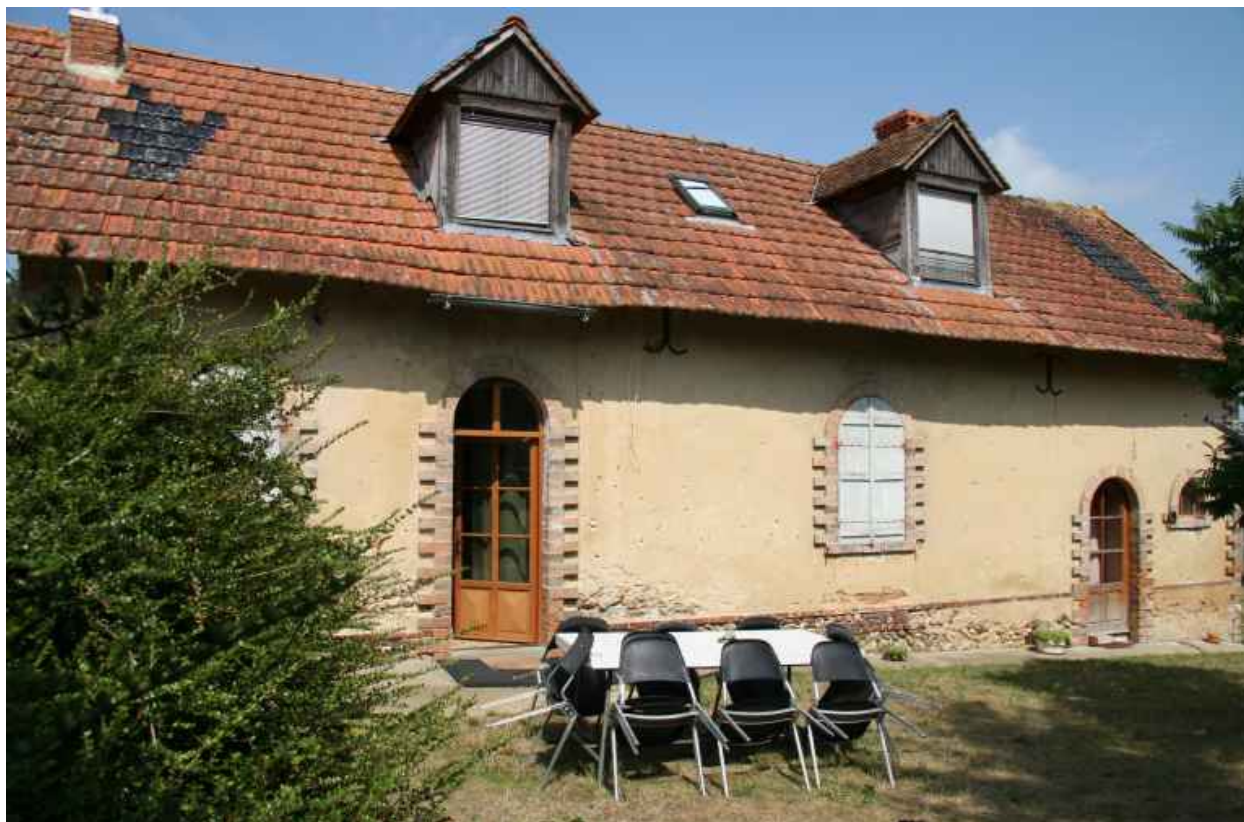
Maison n°5 de garde de la Rolitière : façade antérieure.
