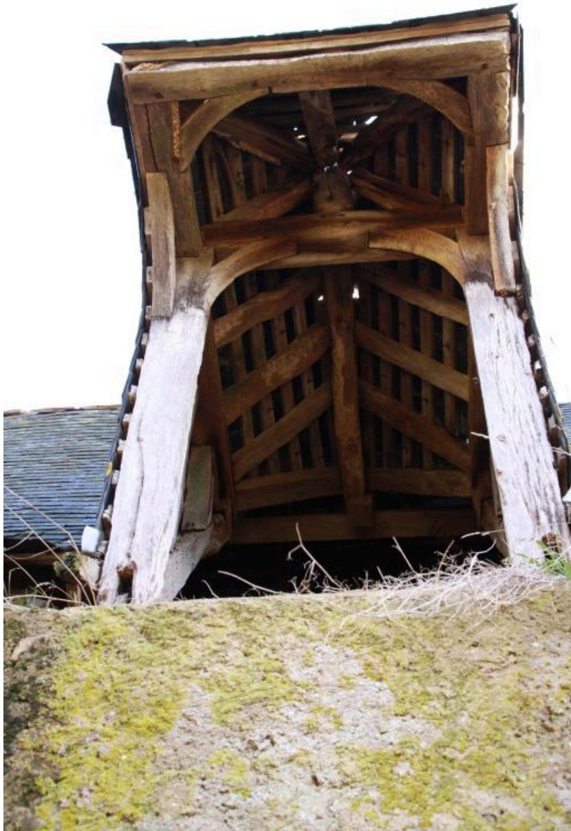
Etable 1, lucarne, détail : charpente.
