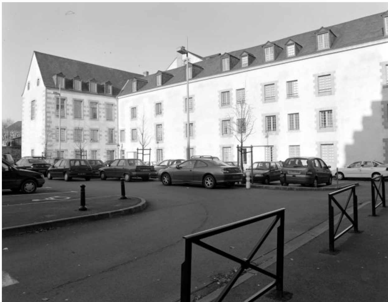
Couvent, corps de logis et aile (après restauration) : vue d'ensemble depuis le sud.
