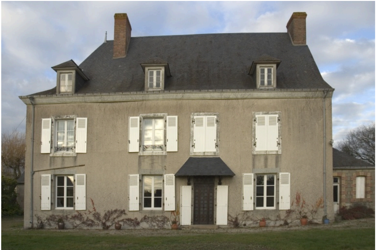
La façade principale du logis vue depuis le sud.
