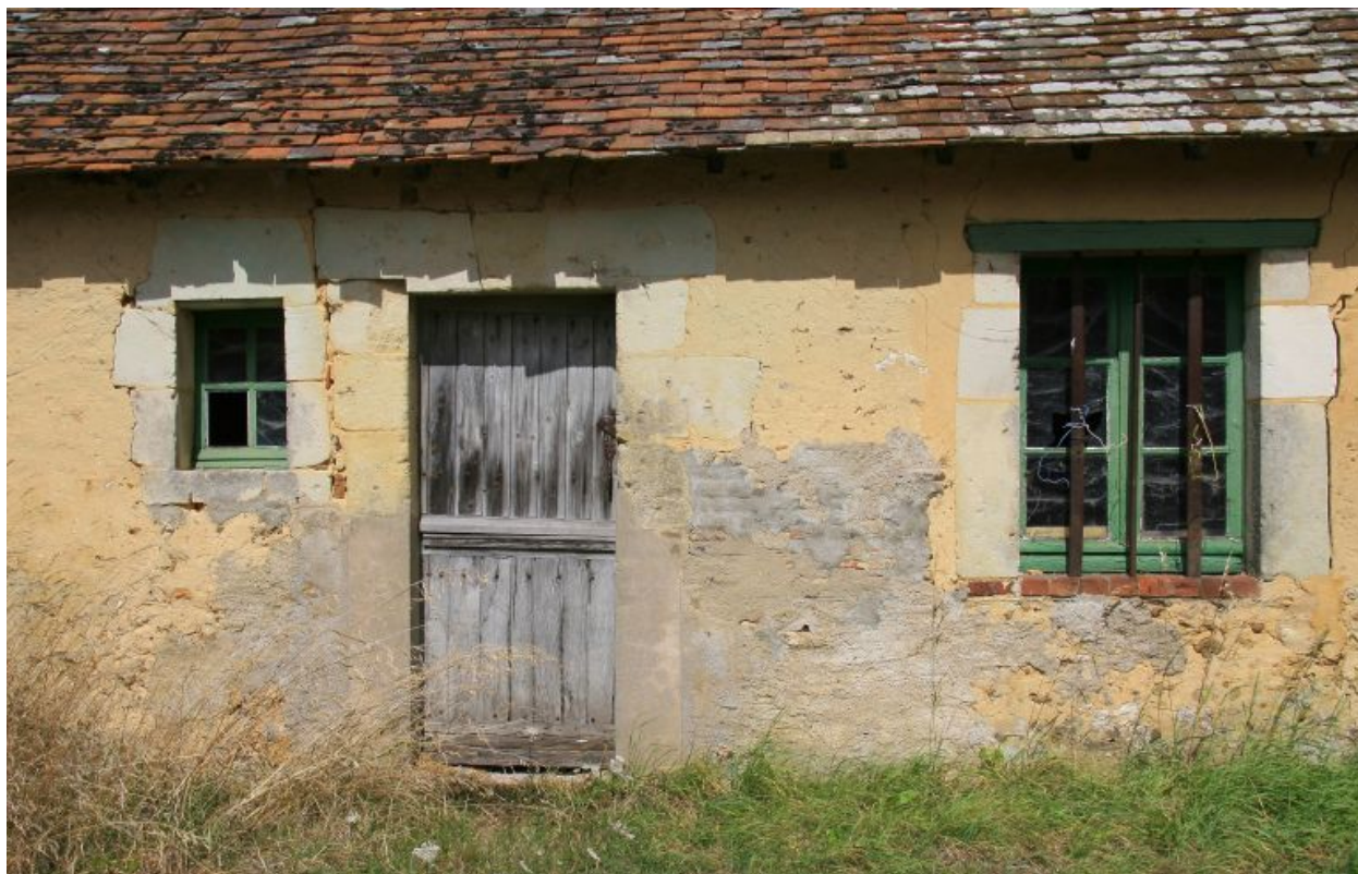
Maison n° 1 : chambre à feu.
