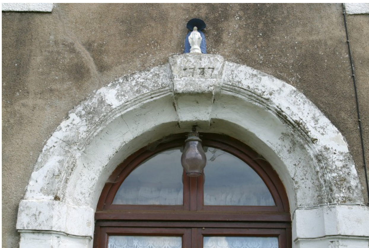
Détail de l'élévation principale du logis : la date portée sur l'arc de la porte.
