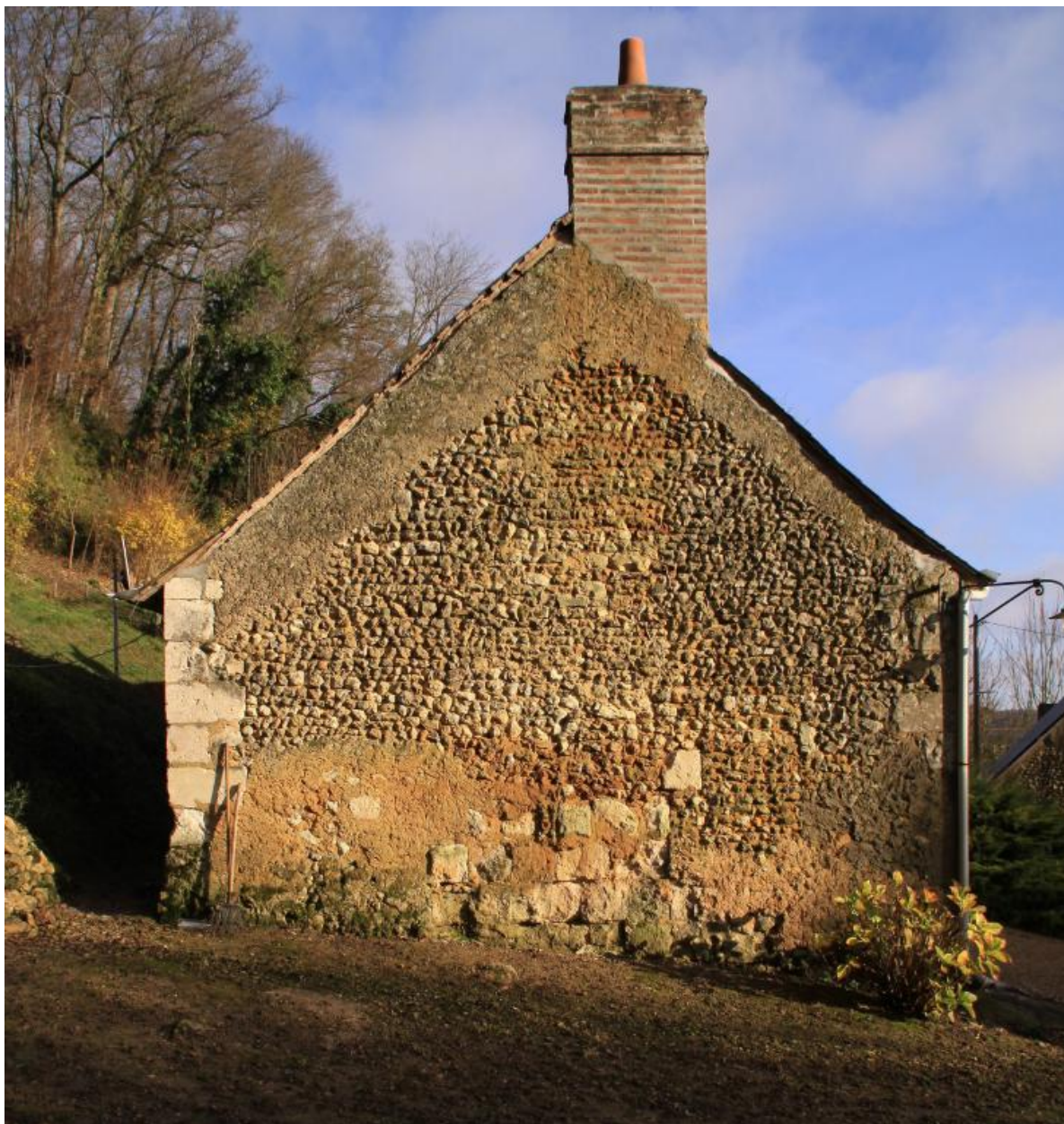
Nouvelle maison : mur-pignon ouest.
