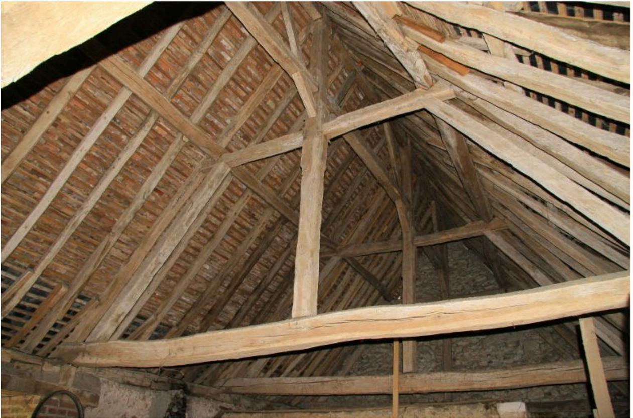
La charpente à pannes avec encoches dans le faux entrait et sous-faîtage.
