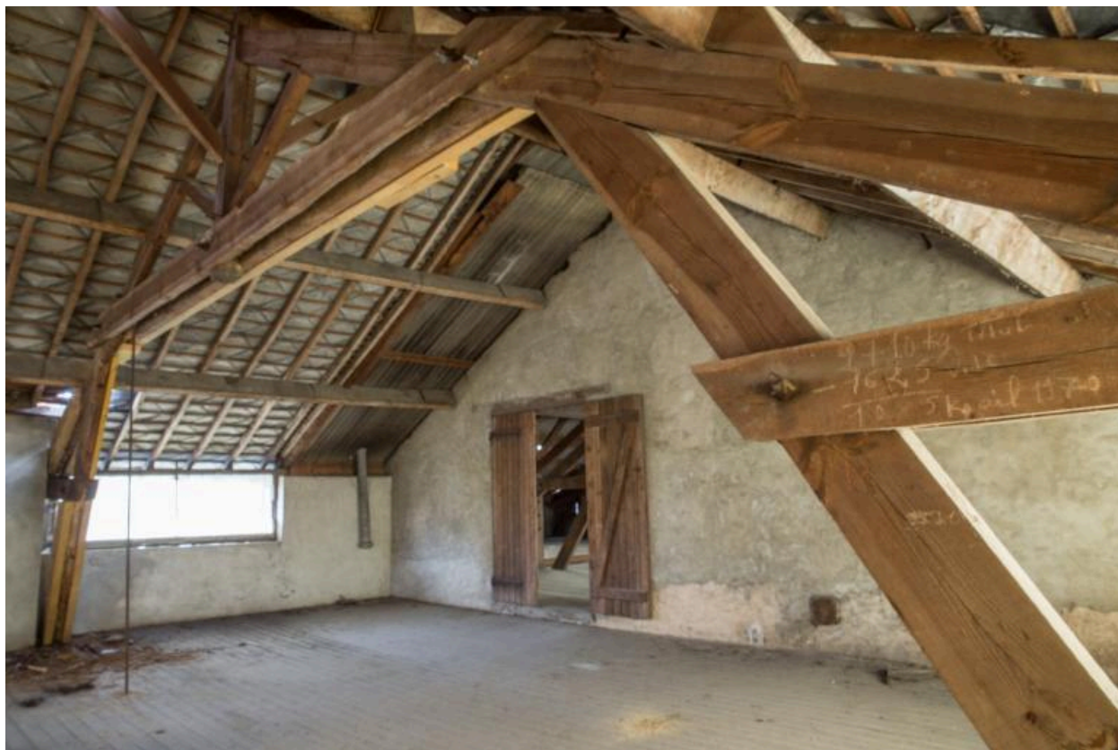
Le comble à surcroît de l'usine.
