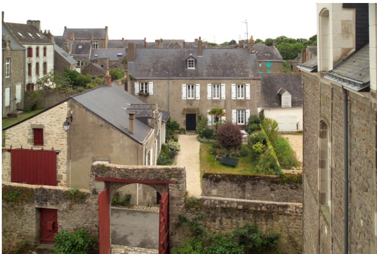
Vue de la partie nord.
