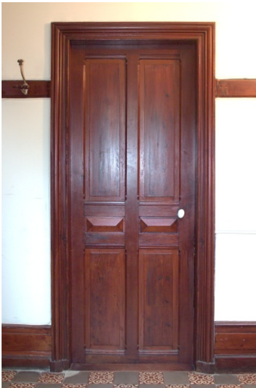
Détail d'une porte dans le hall du rez-de-chaussée.
