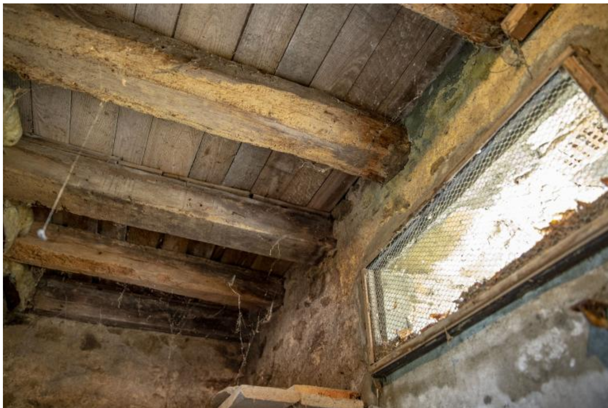
Vue du plafond depuis le rez-de-chaussée de l'annexe agricole.
