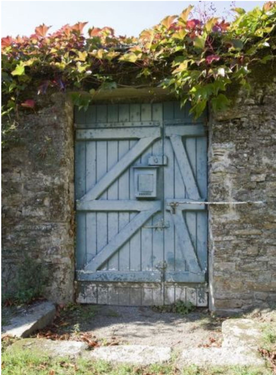
Ancien portail d'entrée vu de la cour.
