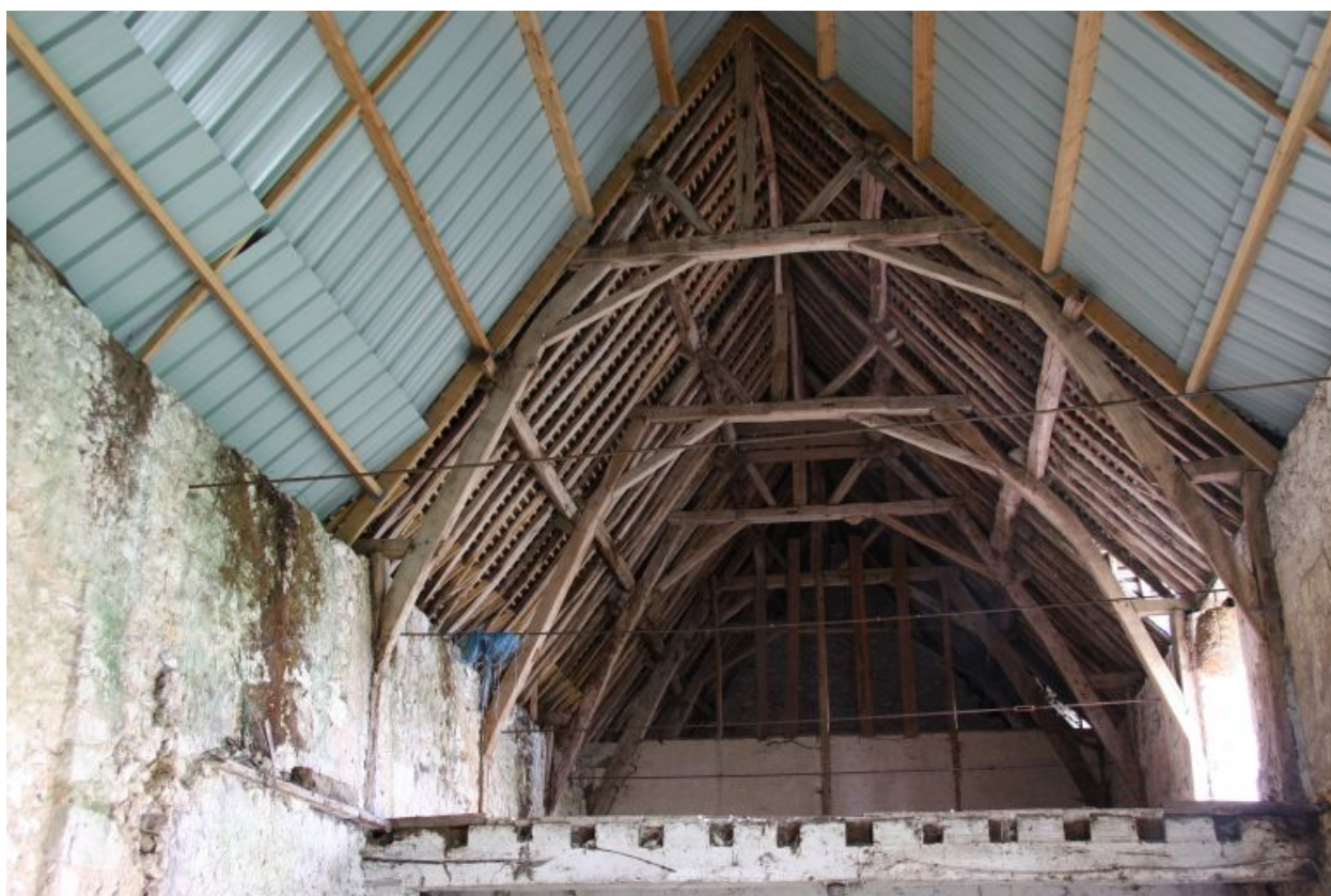
Les communs : charpente côté ouest.
