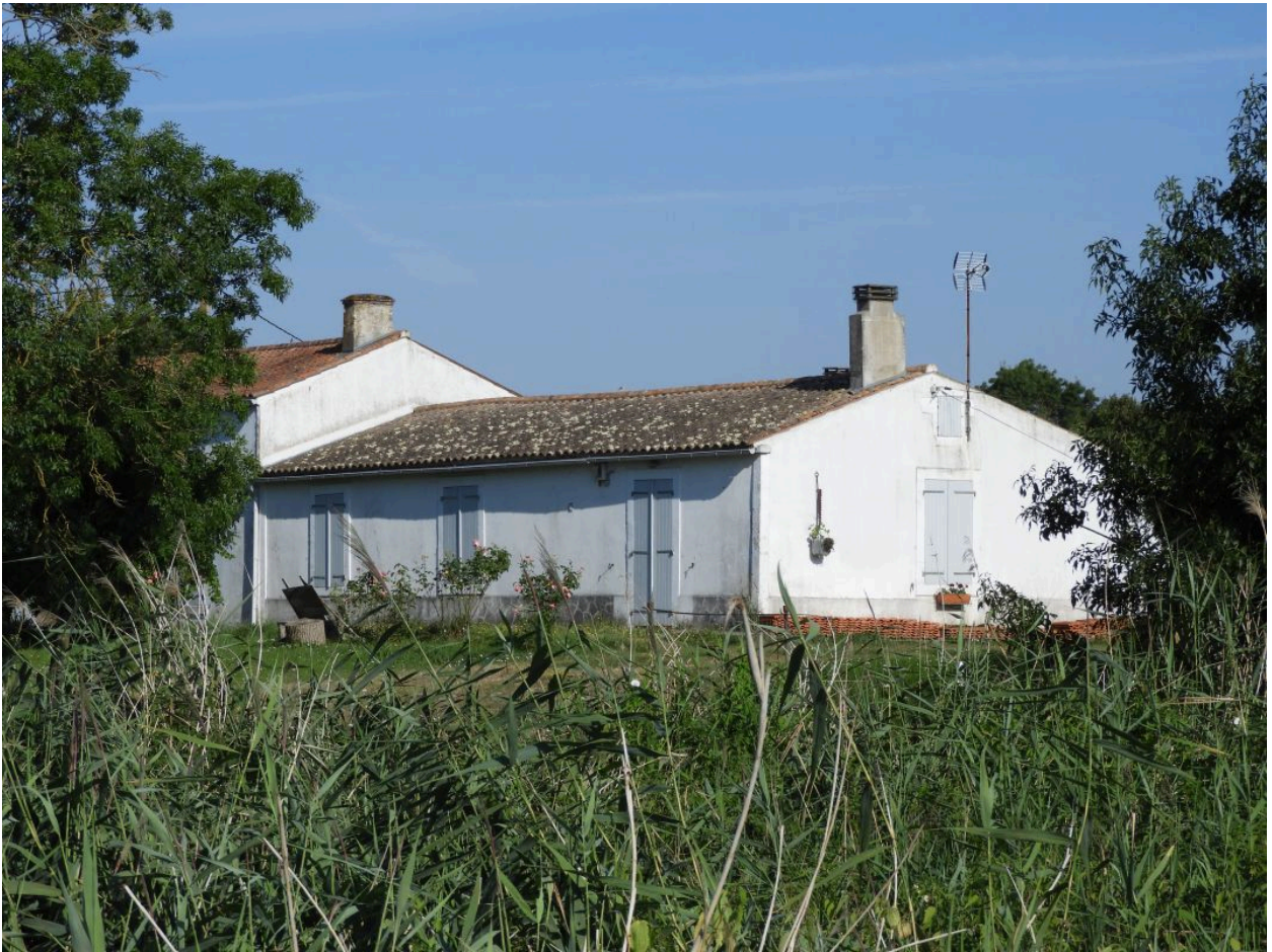
L'extension en rez-de-chaussée vue depuis le sud-est.
