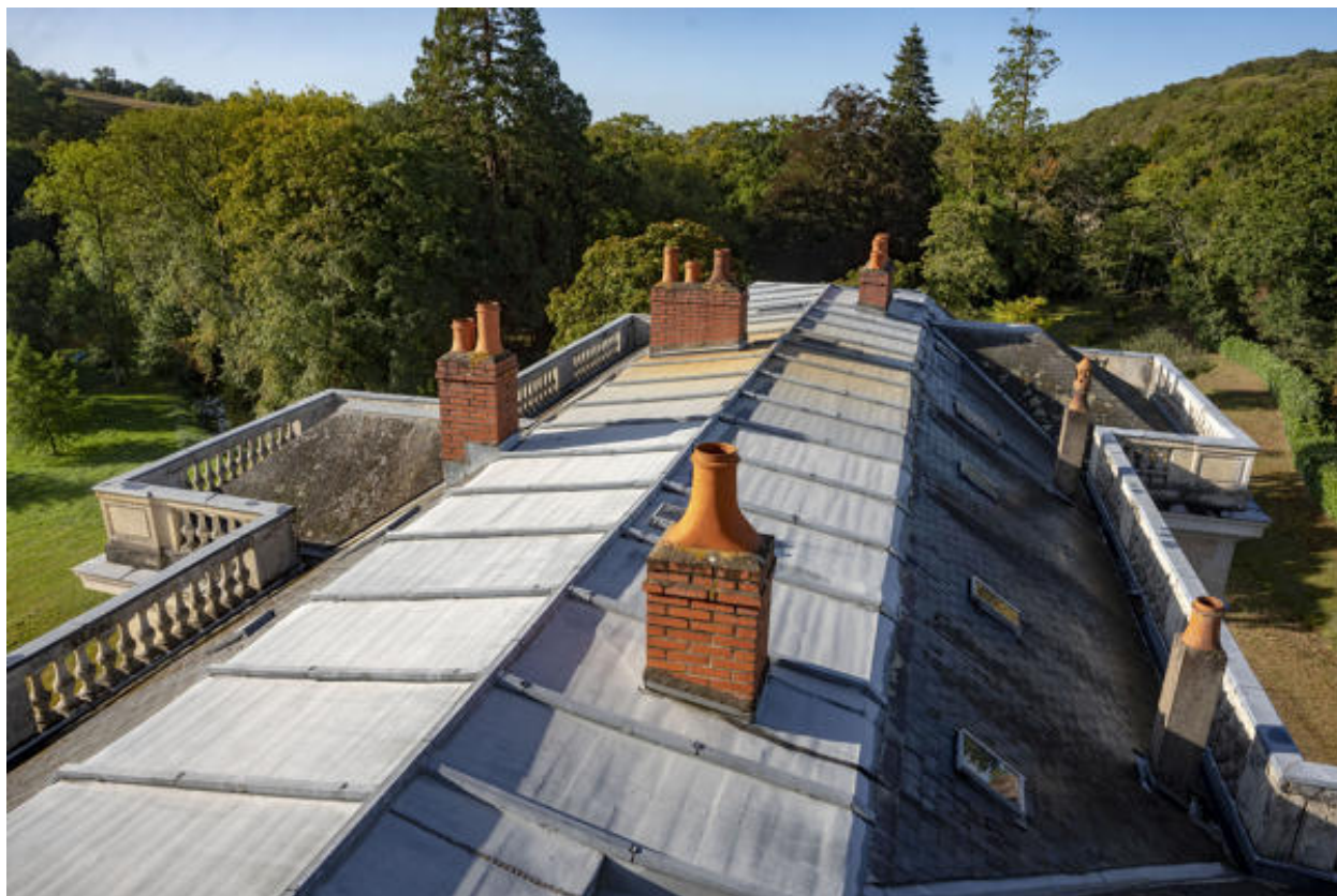
La toiture du château.
