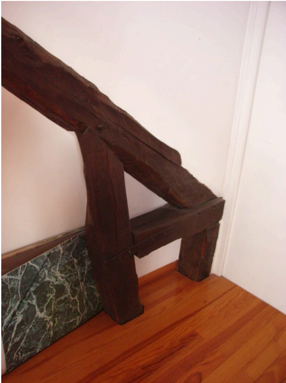
Détail de charpente de la partie sur rue.
