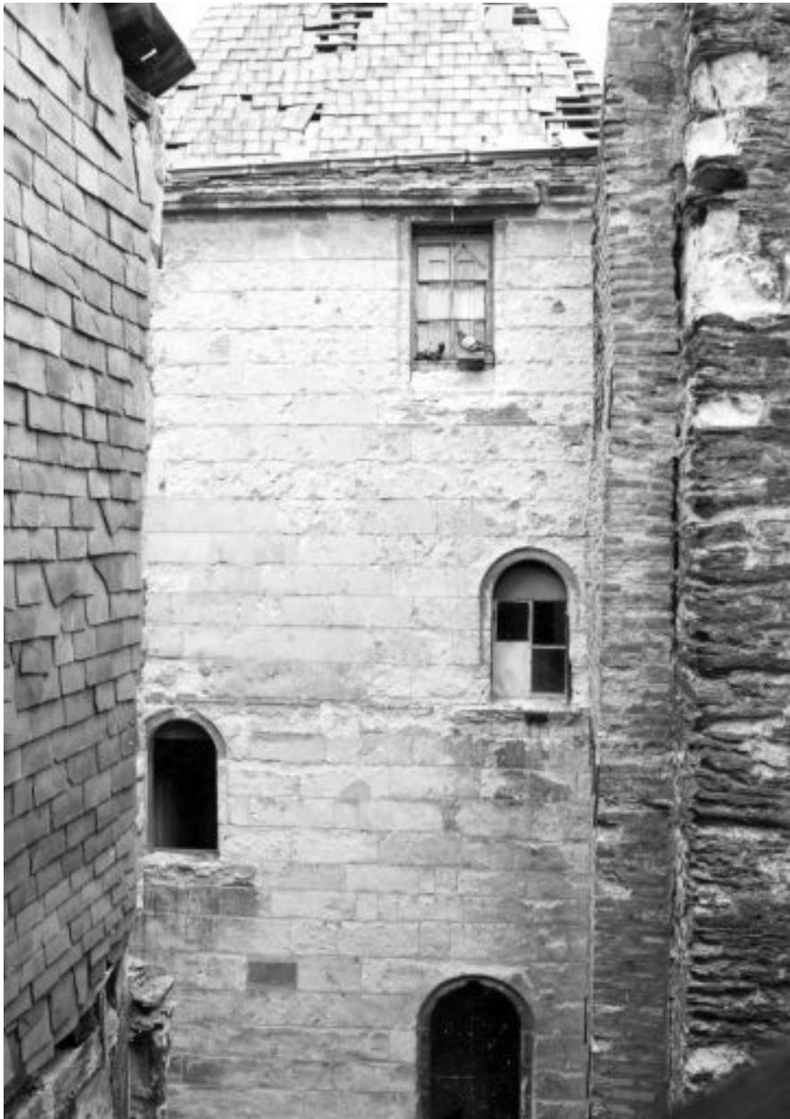
Corps d'escalier, façade est.
