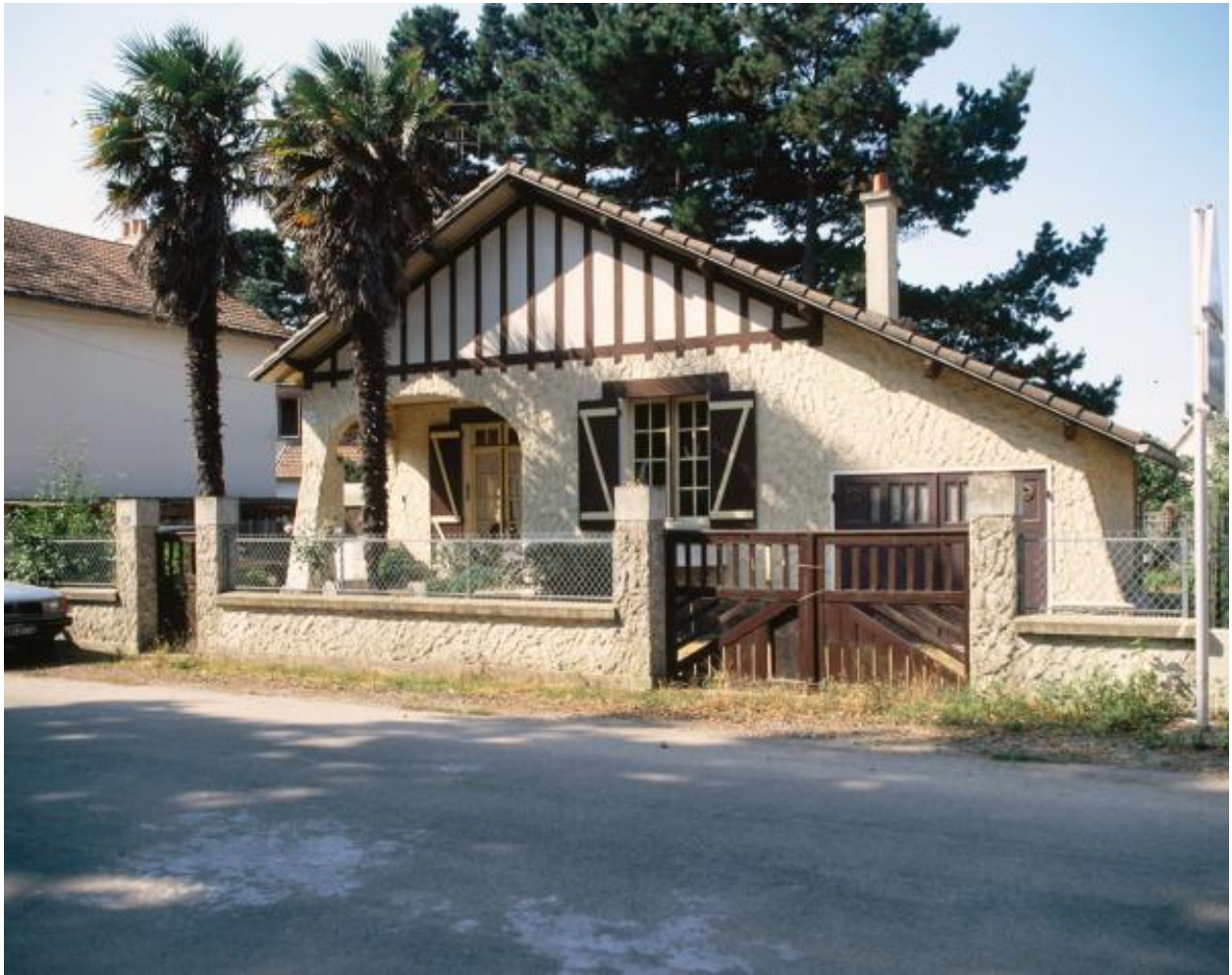
Elévation antérieure de la villa.
